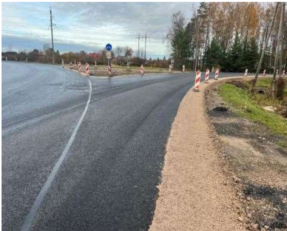
Aizsargu ielas rotācijas apļa asfaltbetona seguma atjaunošana
