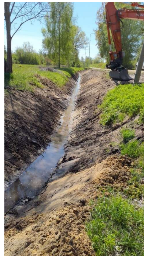
Vītoliņu ceļa caurteka
