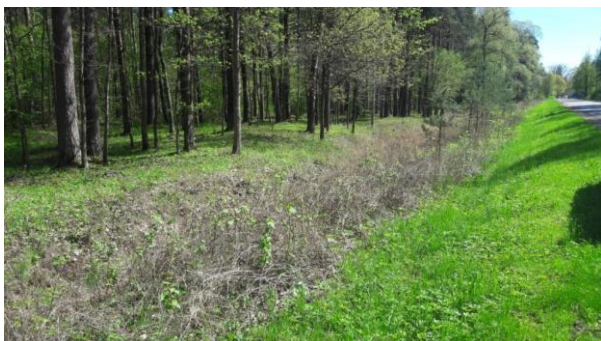
Bauskas iela pirms darbiem
