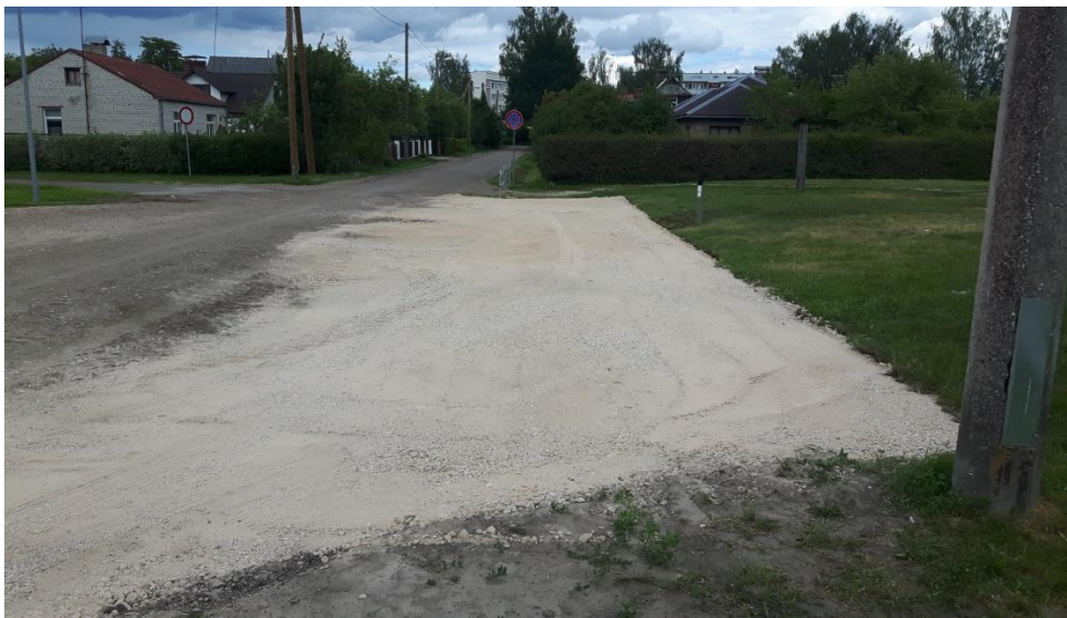
Zvaigžņu iela pie PII "Rotaļa", autostāvvietas uzbēršana ar nesaistītu minerālmateriālu
